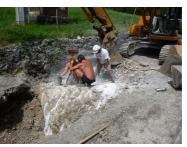
...ainsi que d'un premier tronçon du futur réseau fibre optique départemental installé avec une trancheuse...
