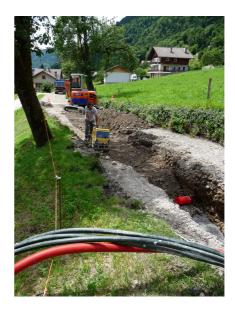
...à ces travaux se sont ajoutés la mise en souterrain des réseaux électriques haute et basse tension, un nouveau transformateur, réalisés conjointement avec la Régie de Thônes....
