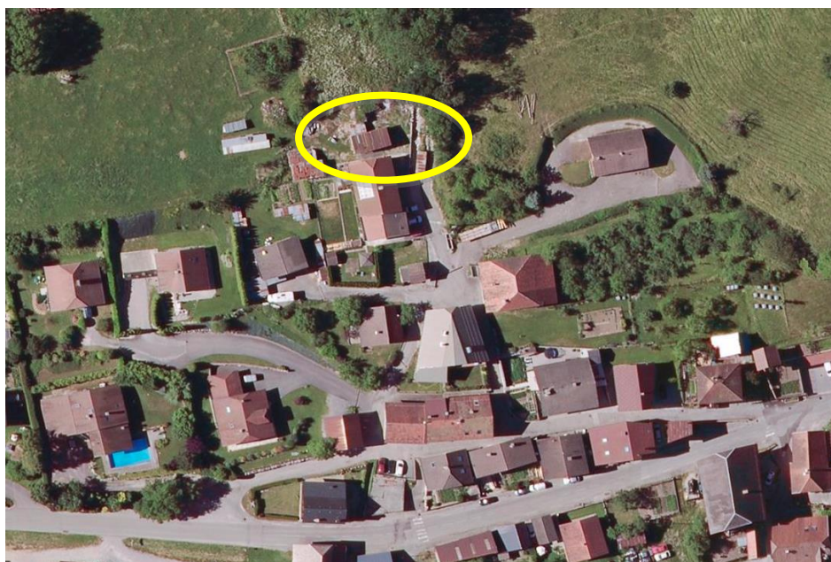
photo aérienne du site – source Géoportail
