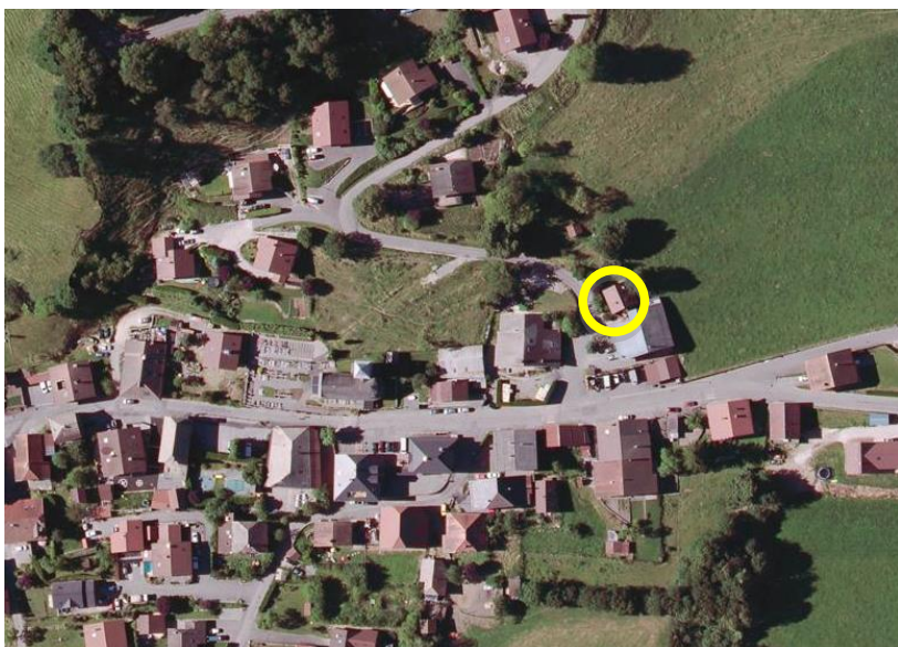
photo aérienne du site – source Géoportail
